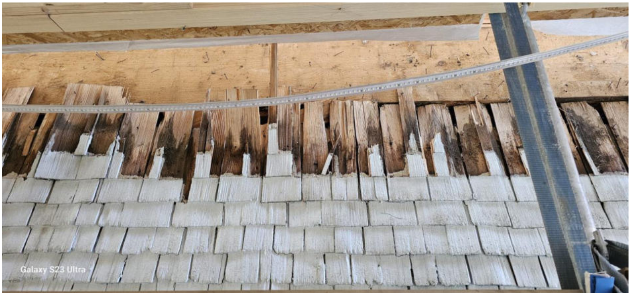
Abriss der Schindelfassade
