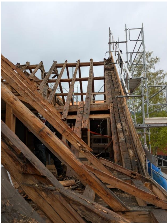
Alter Dachgiebel (Vor dem Umbau)
