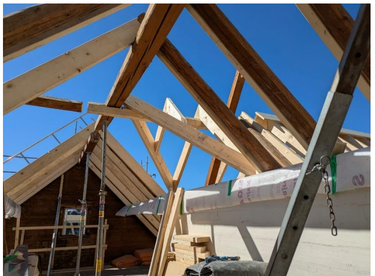
Neuer Dachgiebel (Nach Verstärkung)
